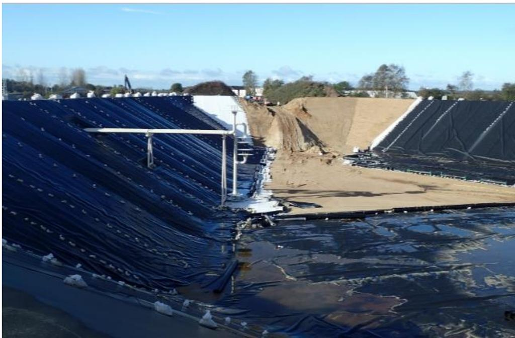
*Figura 2.5.5. Fase di costruzione di un WGPTES.*
